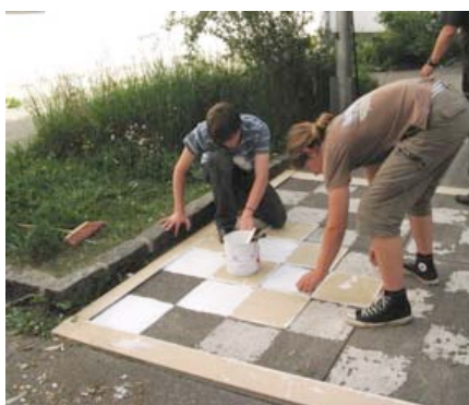
Renovierungsarbeiten im Gefängnishof
